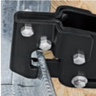
Das Stempelwerkzeug wird durch die Profilbleche gedrückt
